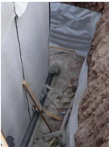
Figura 19: Pozo canadiense en construcción
