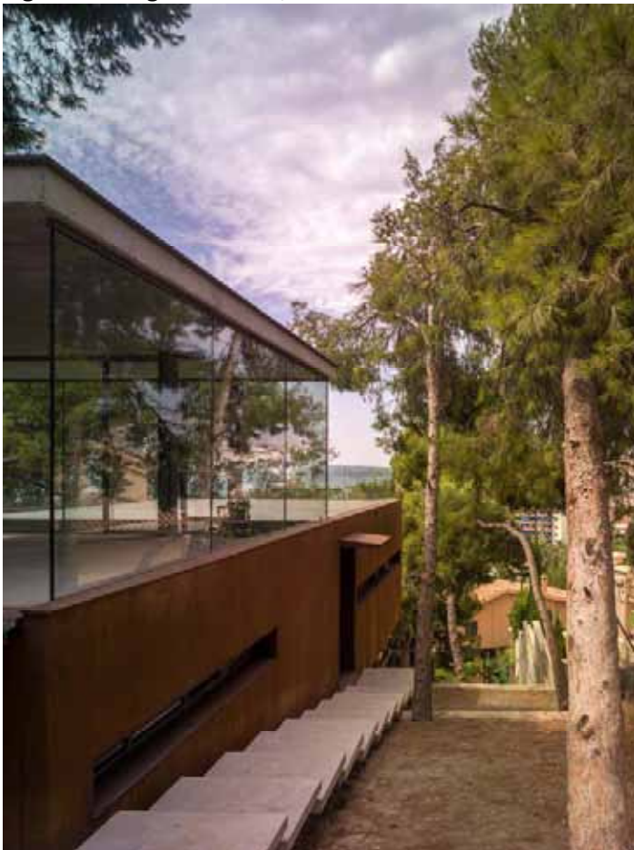
Figura 10: Imagen exterior, fachada norte
