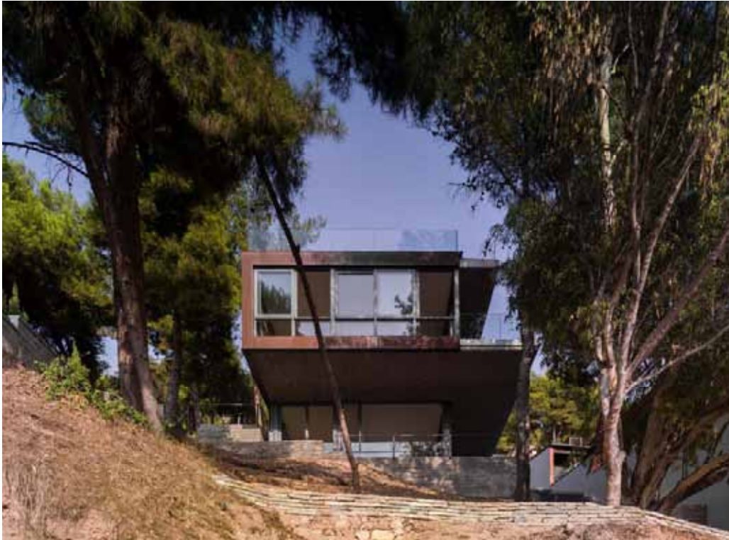
Figura 9: Imagen exterior, fachada oeste
