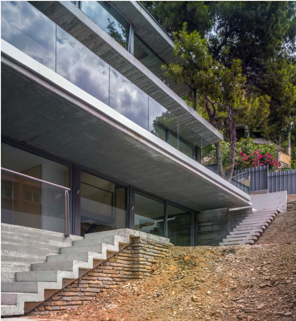
Figura 11: Imagen exterior, fachada sur
