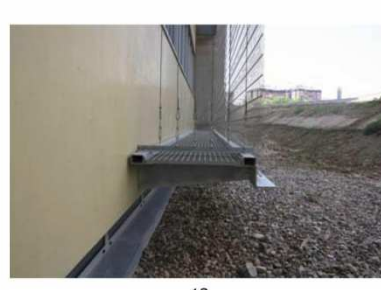
Figura 6. Proceso de colocación de estructura auxiliar, pasarelas y malla de acero inoxidable (Sánchez Medrano)
