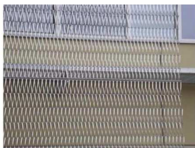
Figura 6. Proceso de colocación de estructura auxiliar, pasarelas y malla de acero inoxidable (Sánchez Medrano)
