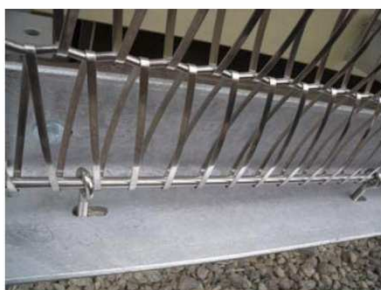
Figura 6. Proceso de colocación de estructura auxiliar, pasarelas y malla de acero inoxidable (Sánchez Medrano)
