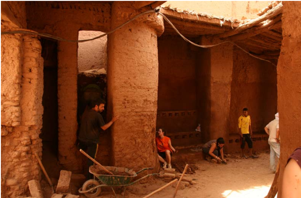
Figura 7: Trabajo de restauración de la Puerta Oeste de M’hamid el Ghezlane
