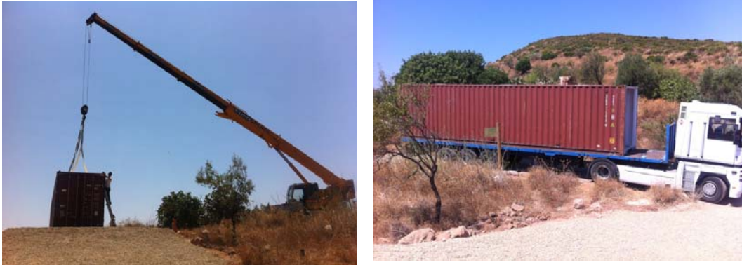
Fig. 5. Imágenes de la colocación de la Antena del EcoCentro.
