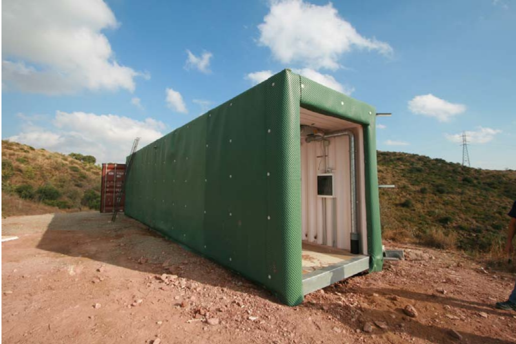
Fig. 8. Imagen de la Antena de EcoCentro en transformación
