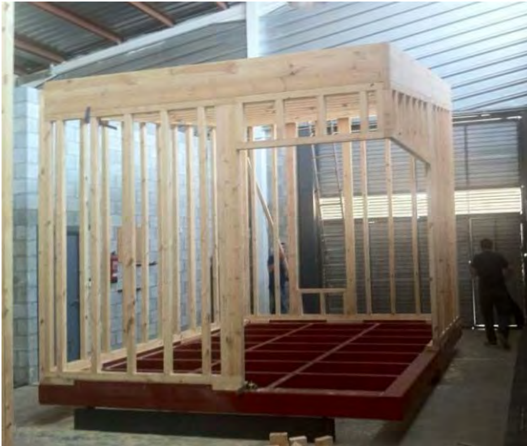
Figura 12. Proceso de replanteo de la vivienda sobre zapatas
