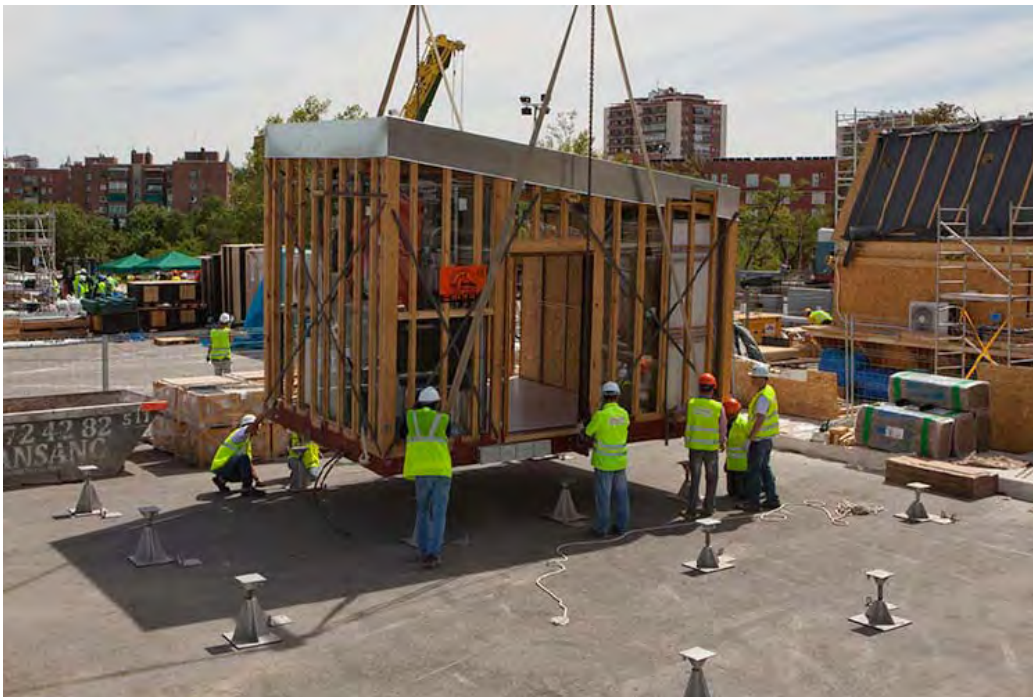
Figura 12. Proceso de replanteo de la vivienda sobre zapatas
