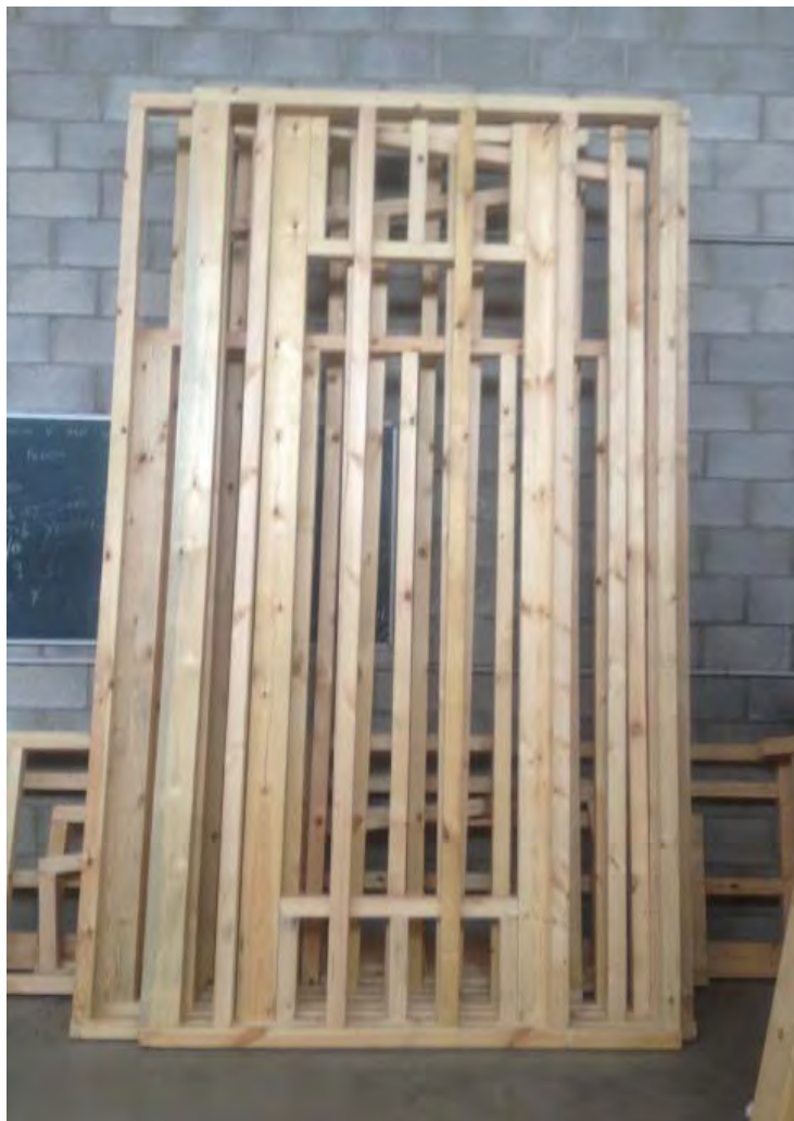
Figura 10. Apilamiento de pórticos industrializados de madera
