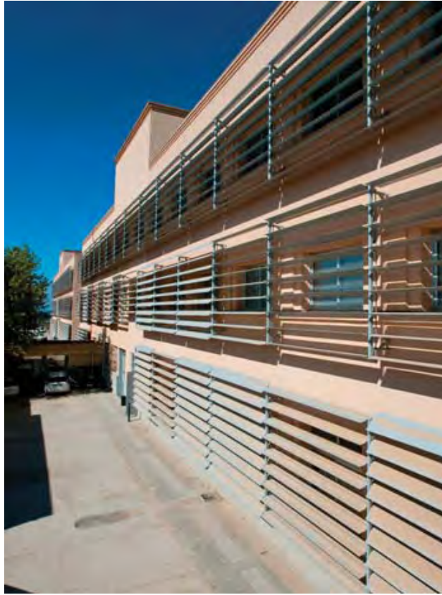
Imagen 9. Fotografía fachadas exteriores del edificio
