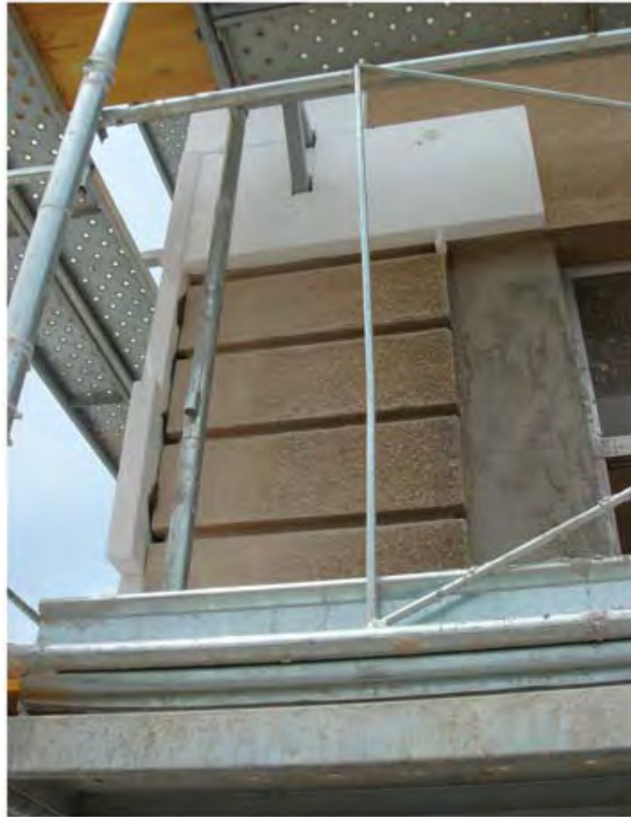
Imagen 8. Detalle de las cubiertas aljibe ecológicas.
