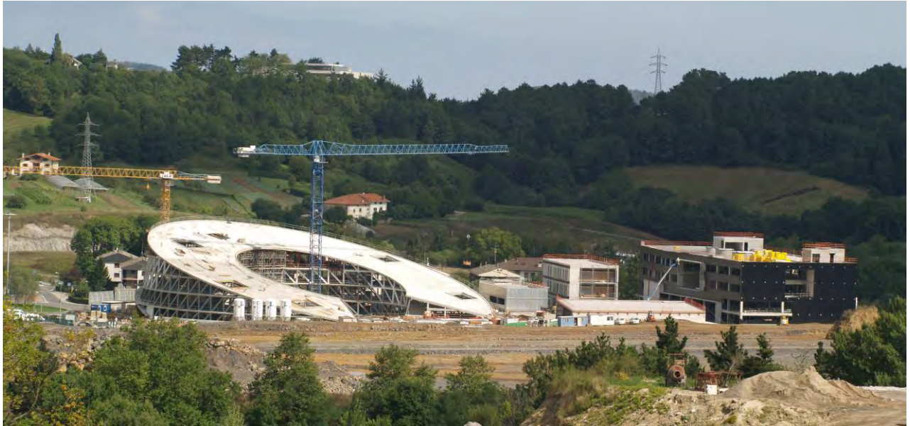
Figura 7. Avance de las obras a Septiembre de 2012.
