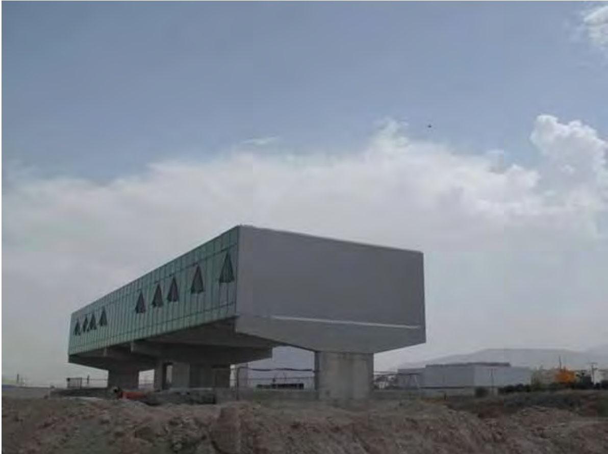
Vista Noroeste del edificio. Fachada Oeste ciega, al igual que la Este.
