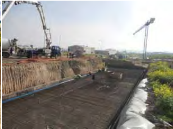
Losa de cimentación
