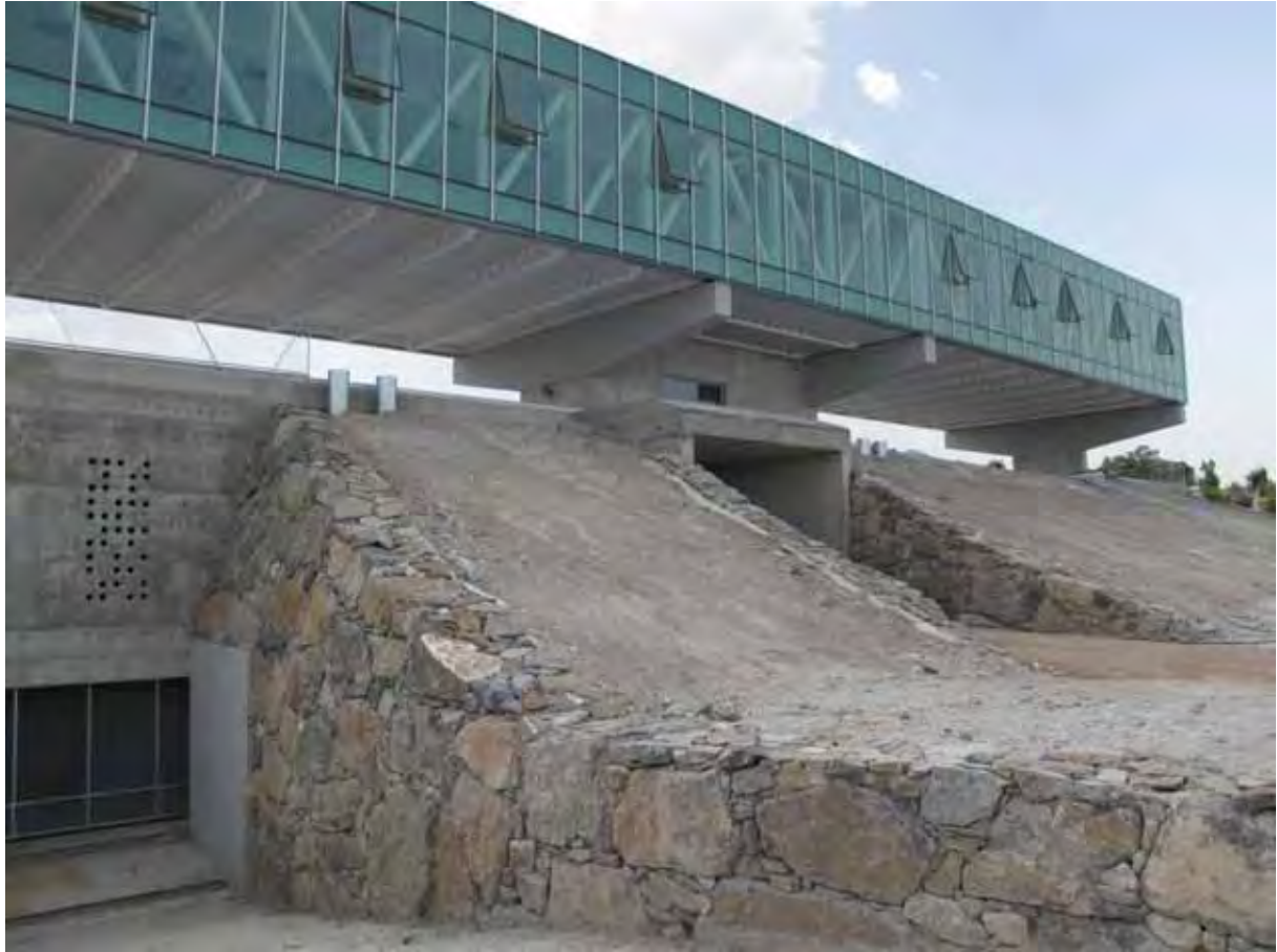
Acceso a garaje, acceso principal, muros de escolleras, y montículo de jardines sin acabar. Norte.
