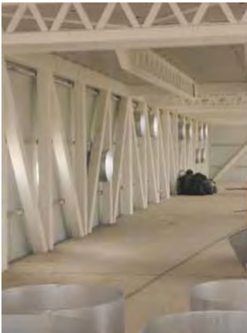
Interior del espacio generado en la planta 2º, donde se aprecia la colocación de los difusores antes de ser cerrado el cerramiento con cámara ventilada. En la imagen siguiente aparece el tamaño y forma de los difusores.
