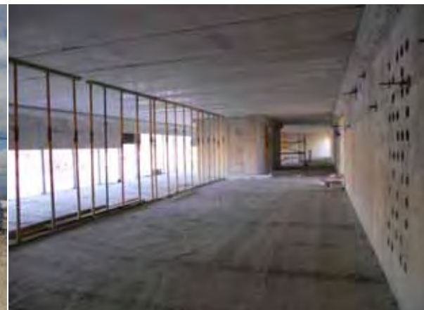
Interior de la Baja. Forjado planta 1º acabado.
