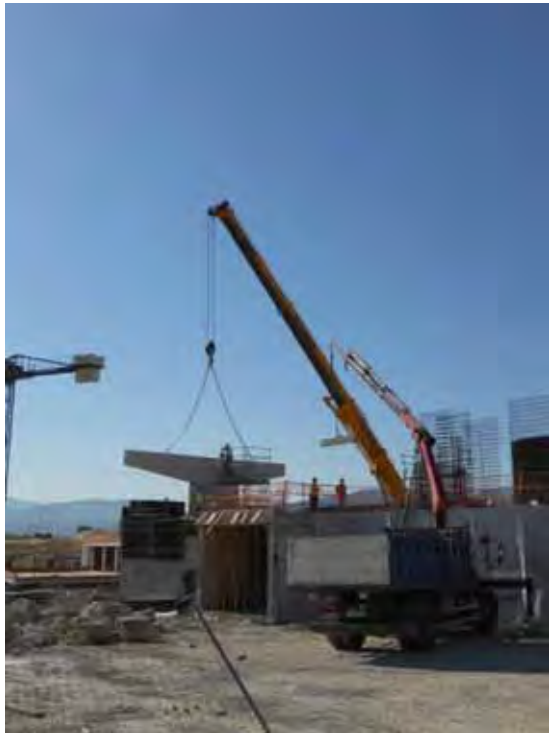
Colocación de las vigas en ménsula prefabricadas
