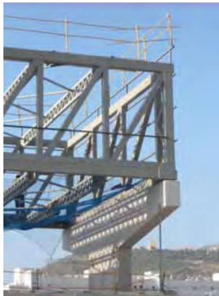
Detalle de apoyo en viga prefabricada del extremo de la estructura metálica
