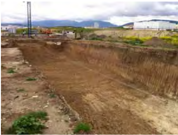
Excavación del solar. La tierra se vierta al solar vecino.
