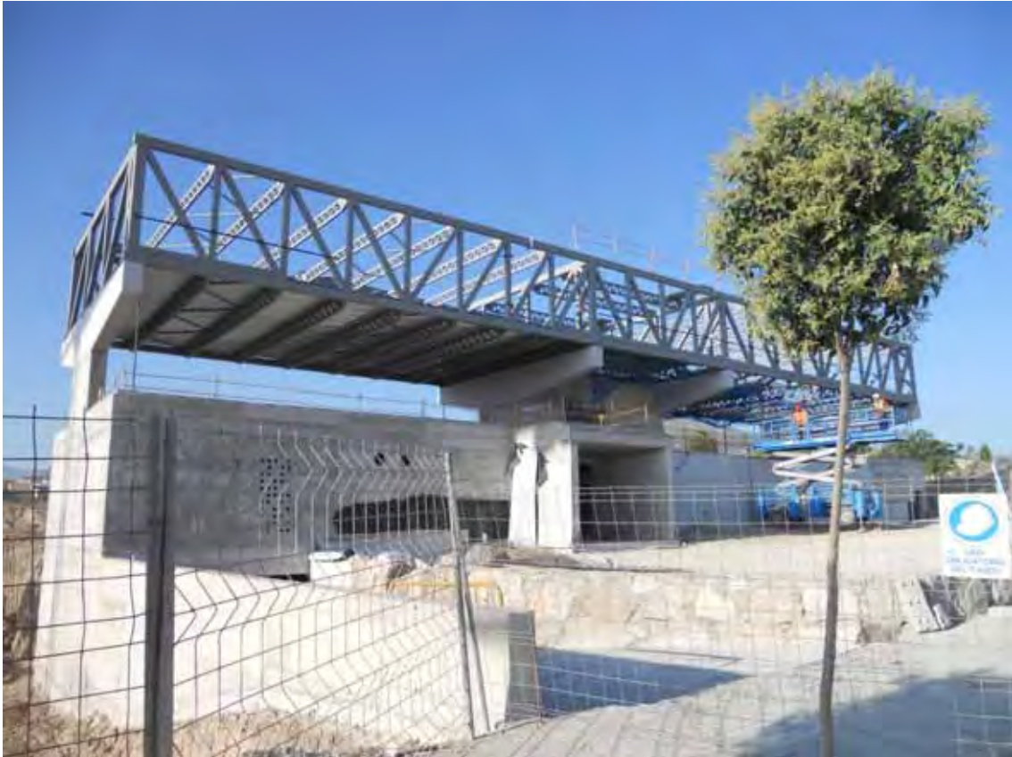
Preparando el forjado con chapa colaborante
