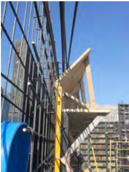
Encofrado para las ménsulas de apoyo.
