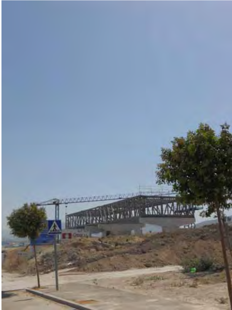
Montaje terminado de los tres módulos estructurales que definen la planta 2º
