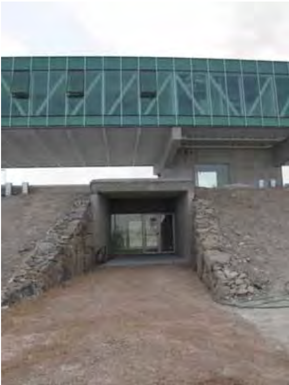
Vista del acceso principal al edificio mediante la grieta entre jardines, sin acabar.
