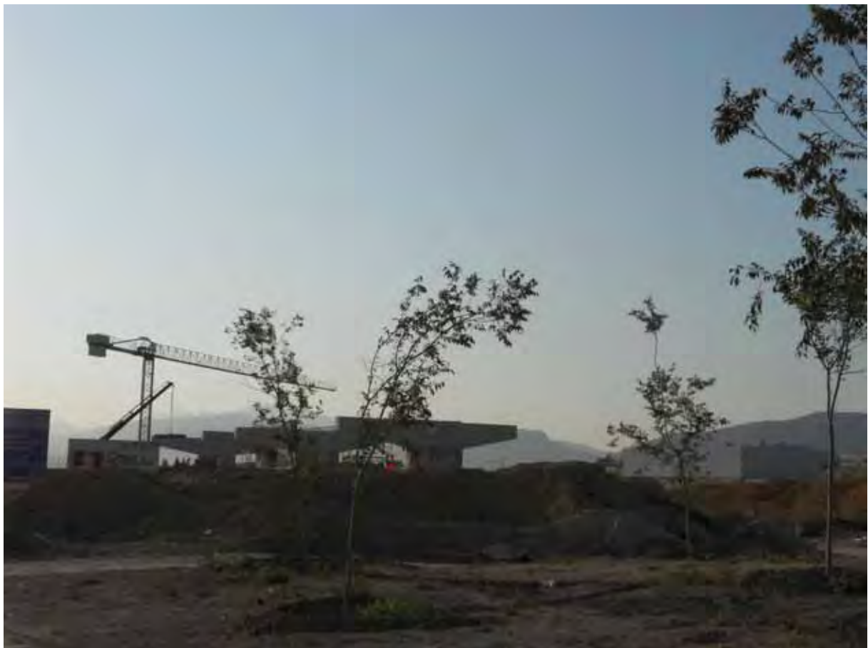
Imagen de los cuatro muros pantalla y las vigas colocadas. Se aprecia la tierra vertida al solar vecino.
