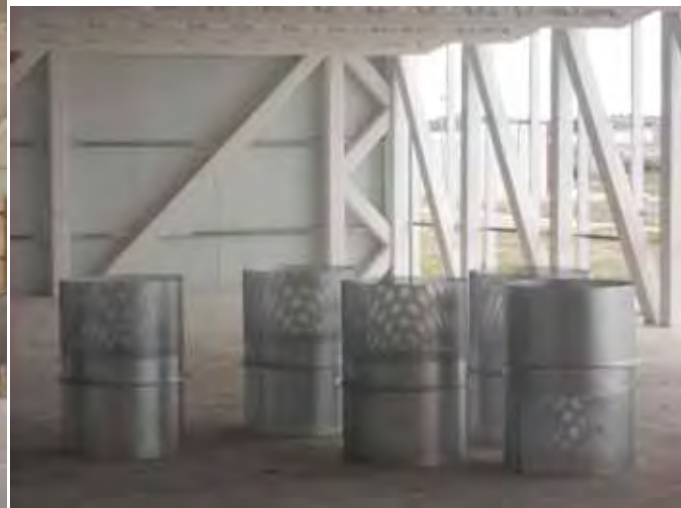
Interior del espacio generado en la planta 2º, donde se aprecia la colocación de los difusores antes de ser cerrado el cerramiento con cámara ventilada. En la imagen siguiente aparece el tamaño y forma de los difusores.
