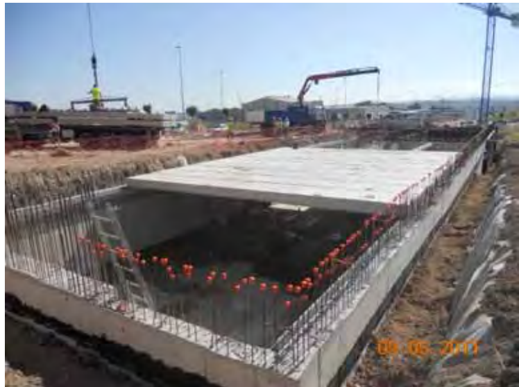
Prefabricados en forjado planta Baja.
