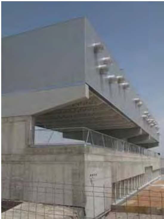
Vista de las fachadas Suroeste y el patio trasero, sin terminar y lista para ajardinar. En la planta baja de esta fachada queda por colocar los brie-soleil lineales para la protección de los huecos.
