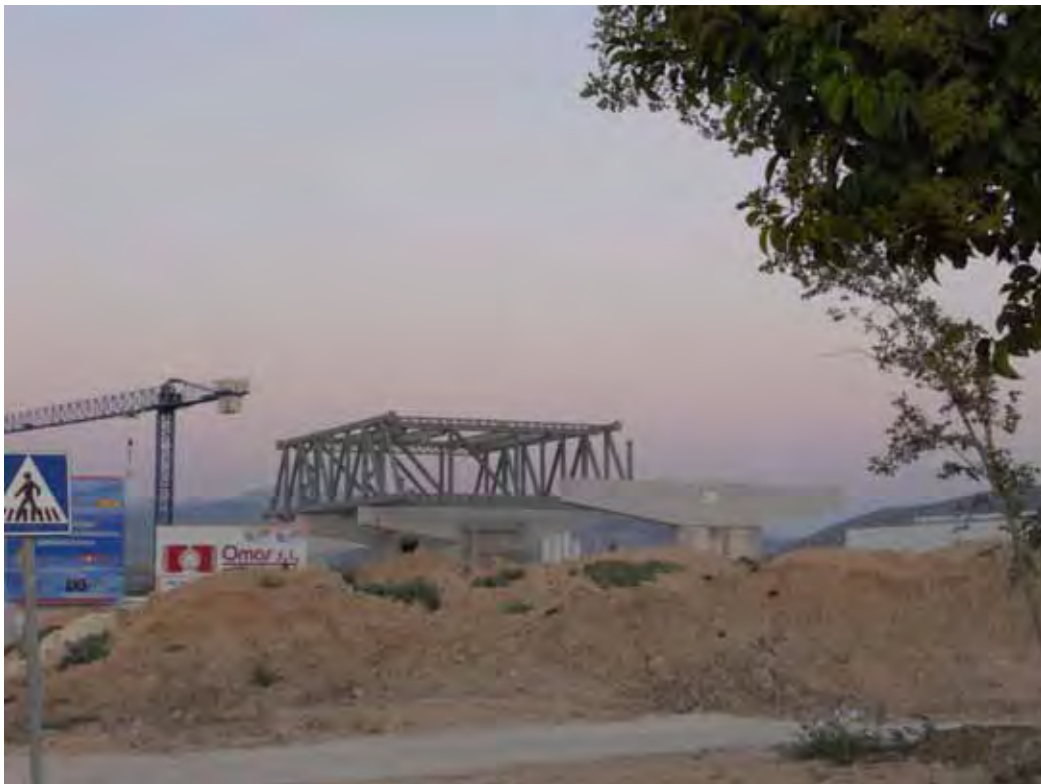
Vista del montaje del módulo central
