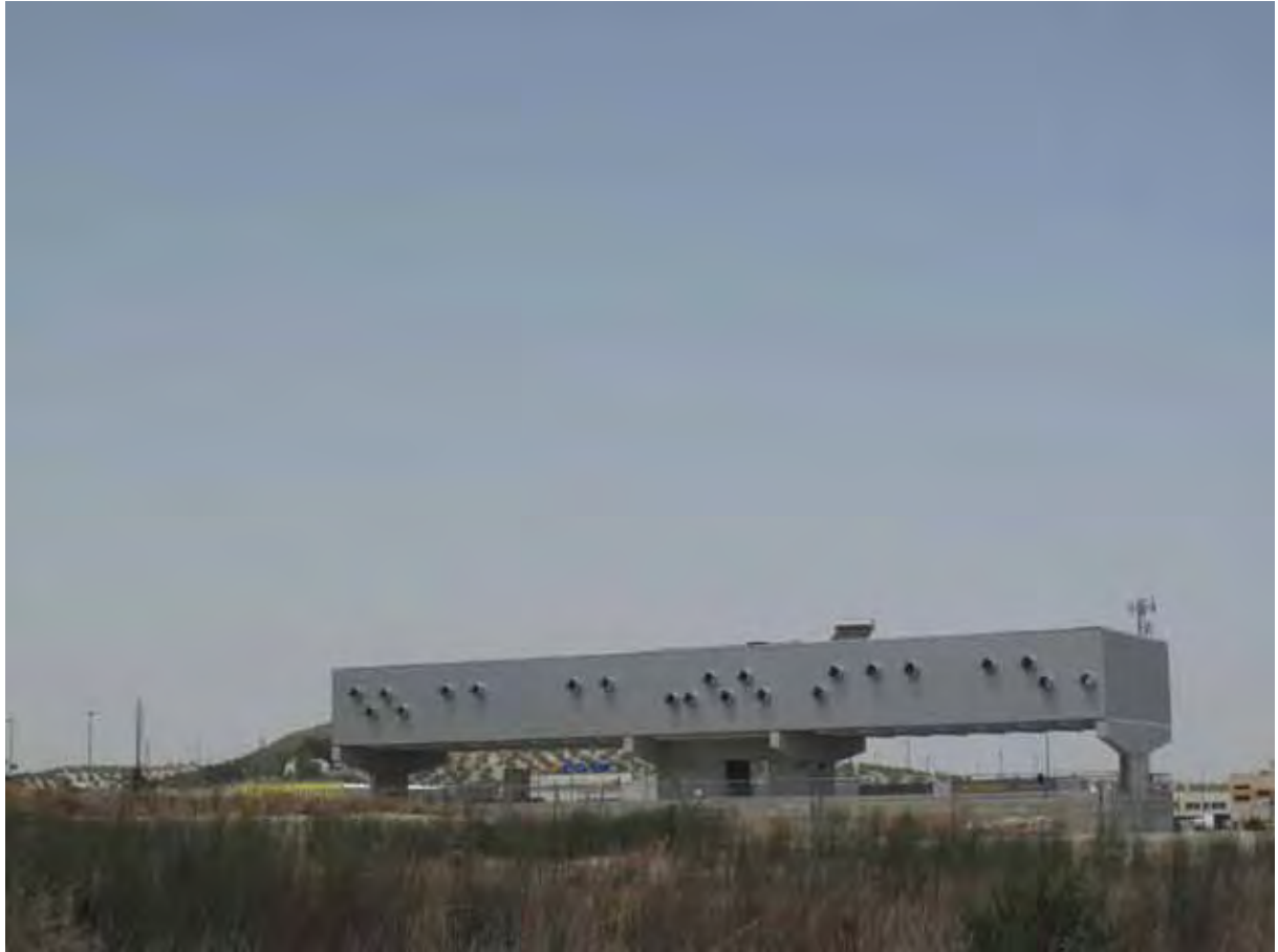
Vista general de la fachada Sur del edificio desde la ciudad.
