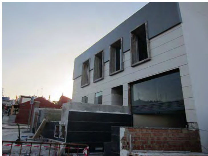
Imagen de la ejecución de las obras del edificio
